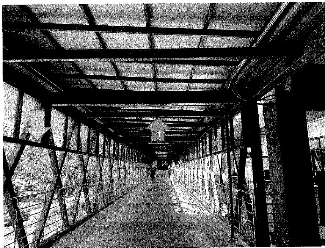
ทางเชื่อมอาคาร สว. ไปยังอาคาร กว.
